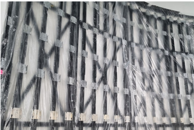
Die SEAMLESS Bespoke Unterkonstruktion verteilt das Gewicht der LEDs und der Halterungen auf dem Boden
